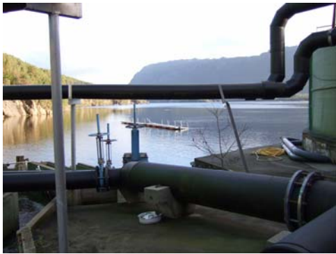
Figur 28: Flytebryggeløsning som nødvendiggjør føringsslanger i sjø
