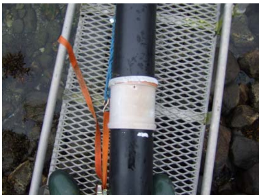
Figur 32: Rørskjøt og festestropp
