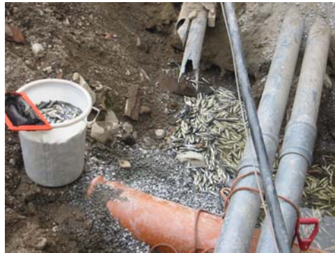
Figur 10: Uhell på grunn av feil rørkobling
