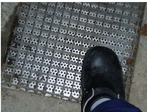
Figur 21: Avløp med sikring, liten lysåpning/hullstørrelse
