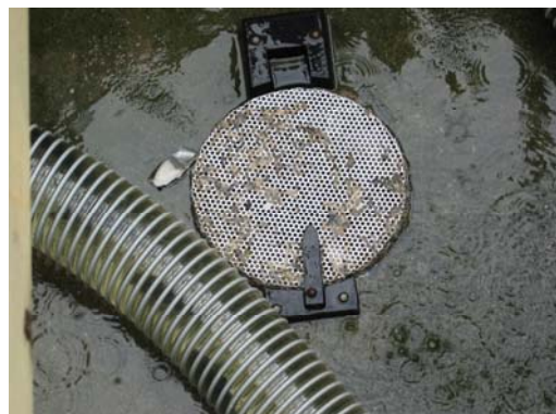
Figur 12: Sikring av avløp i koblingskum
