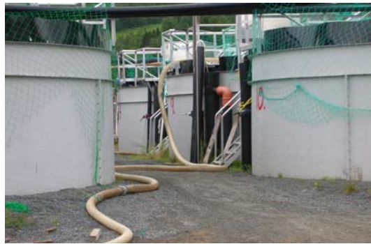
Figur 31: Føringsslanger på kryss og tvers av veien
