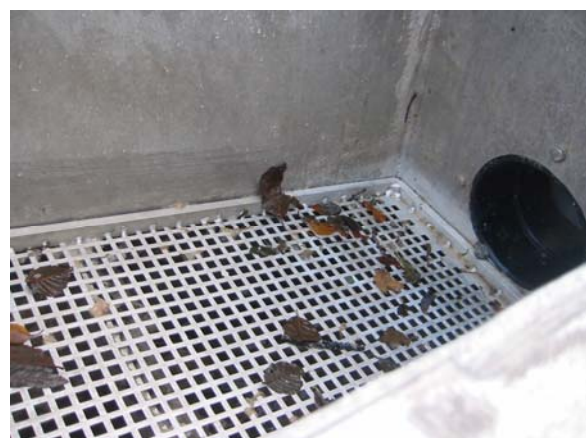
Figur 8: Fastskrudd rist i dødfisksamler
