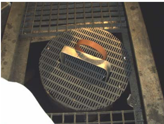
Figur 14: Sikring av senteravløp (”munk”)
