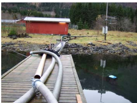
Figur 30: Lange avstander fordrer mange rørsjøter
