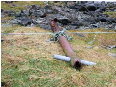
Figur 25: Havarert og mangelfull fortøyingspåle
