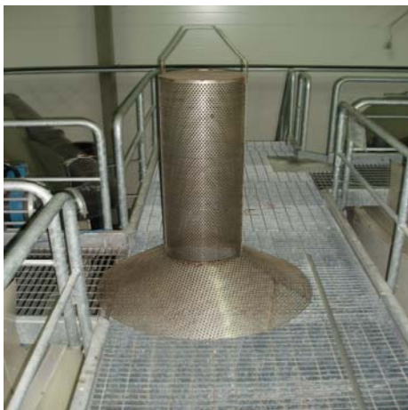
Figur 2: Sil før kollaps
