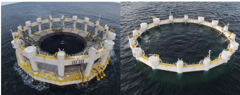
Figur 10 Merdene i hevet (til venstre) og senket (til høyre) posisjon
