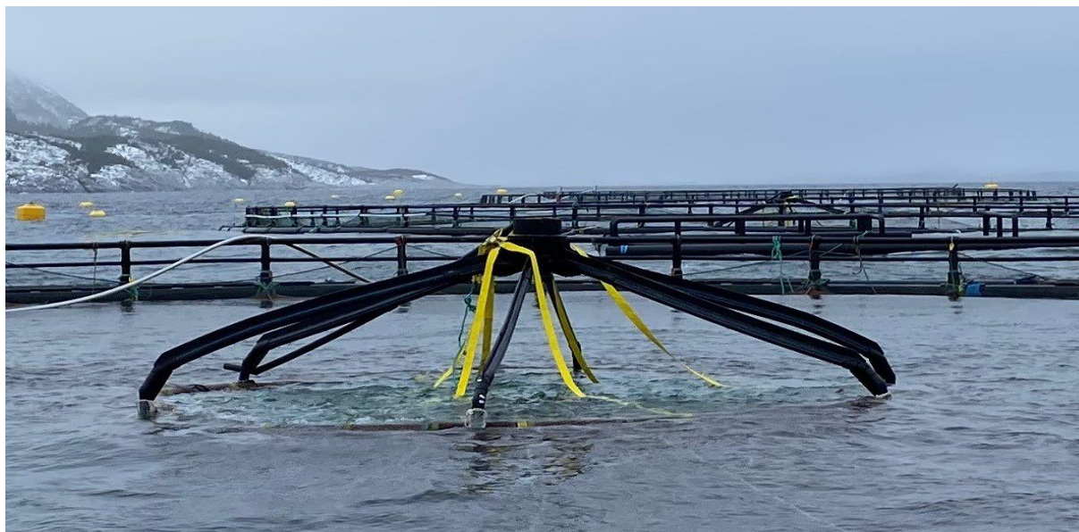
Luftkuppel i hevet posisjon
