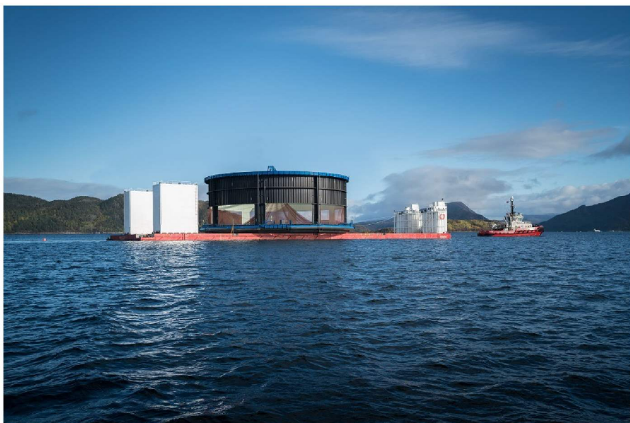
Figur 2 Installasjon av Aquatrax pilotmerd nr.1 i Eiterfjorden
